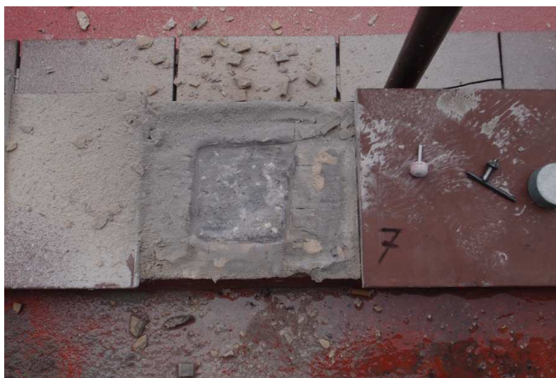
Fot. nr 21 - miejsce pomiarowe M7 – przygotowanie do badania młotkiem Schmidta
