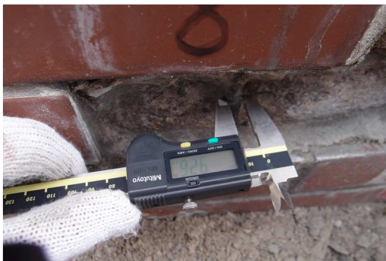
Fot. nr 22 - miejsce pomiarowe nr M8 – sprawdzenie średnicy prętów zbrojeniowych oraz otulenia
